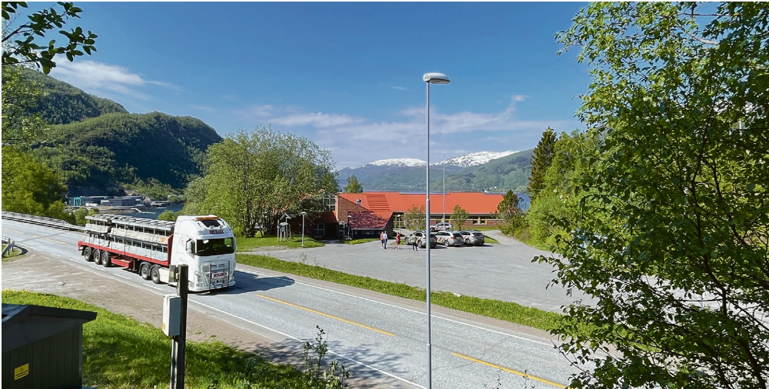
OMFATTENDE. Det skal bli kontorer i tidligere kro- og fellesarealer, hotelldelen skal gjøres om til overnattingshybler for vegvesenets ansatte. Bygget skal blant annet få nytt ventilasjonsanlegg og nytt elektriske anlegg og det skal oppgraderes i forhold til brannforskrift, forteller Statens vegvesen. Foto: Knut Haarvik / Statens vegvesen
